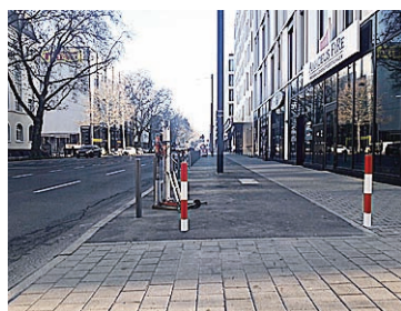
Der erste Abschnitt der Hanauer Landstraße mit verbreitertem Radweg. Nach und nach kommen weitere Abschnitte hinzu. Im Bild ist hinter dem linken Poller eine Pollerbohrmaschine zu erkennen.
