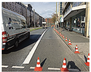
Die Konrad-Adenauer-Straße unmittelbar vor der Rotmarkierung. Foto: Amt für Straßenbau und Erschließung (ASE)
