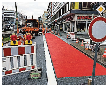
Die Konrad-Adenauer-Straße in fast schon wieder befahrbarem Zustand. Foto: Amt für Straßenbau und Erschließung.
