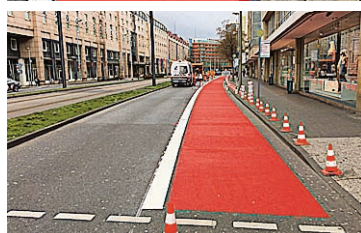
Bild oben: Die Kurt-Schumacher-Straße während der Markierungsarbeiten. Foto: Amt für Straßenbau und Erschließung.
